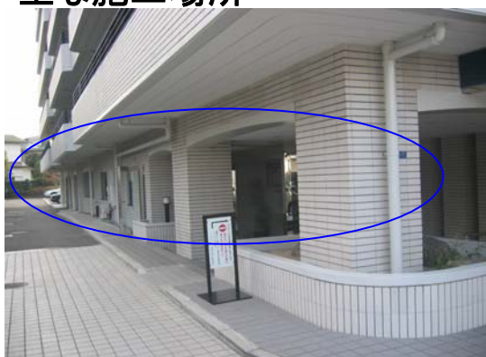
1階エントランス左横から駐車場入口まで
